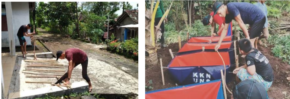
Gambar 1. Persiapan pembuatan kerangka kolam bioflok terpal dan pemasangan kerangka, serta menyiapkan kolam terpal
