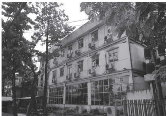
写真2-13 エアコン完備のH社中国人職員宿舎
