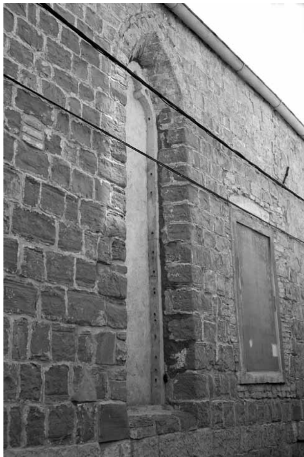
Sl. 22: Piran, minoritska cerkev, zazidano okno na zunanjščini srednje kapele ob severni strani ladje (foto: M. Oter Gorenčič).
