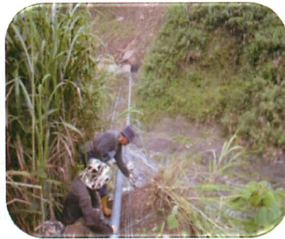
図6 森林火災防止のための消火用送水設備の構築
