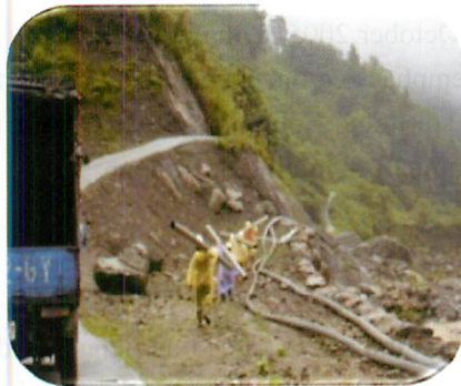
図6 森林火災防止のための消火用送水設備の構築
