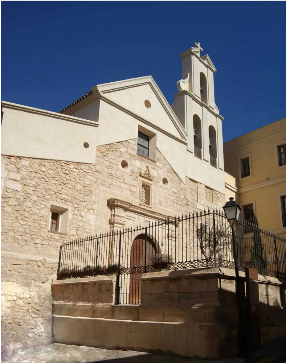
Figura 8. Melilla, iglesia de la Purísima Concepción. Fachada tras la recuperación de elementos y estructuras originales en 2019 ( https://melillamonumental.es/wp-content/uploads/2019/06/Iglesia-de-la-Pur%C3%ADsima-Concepci%C3%B3n-Principal.jpg , última consulta 2 de diciembre de 2021).
