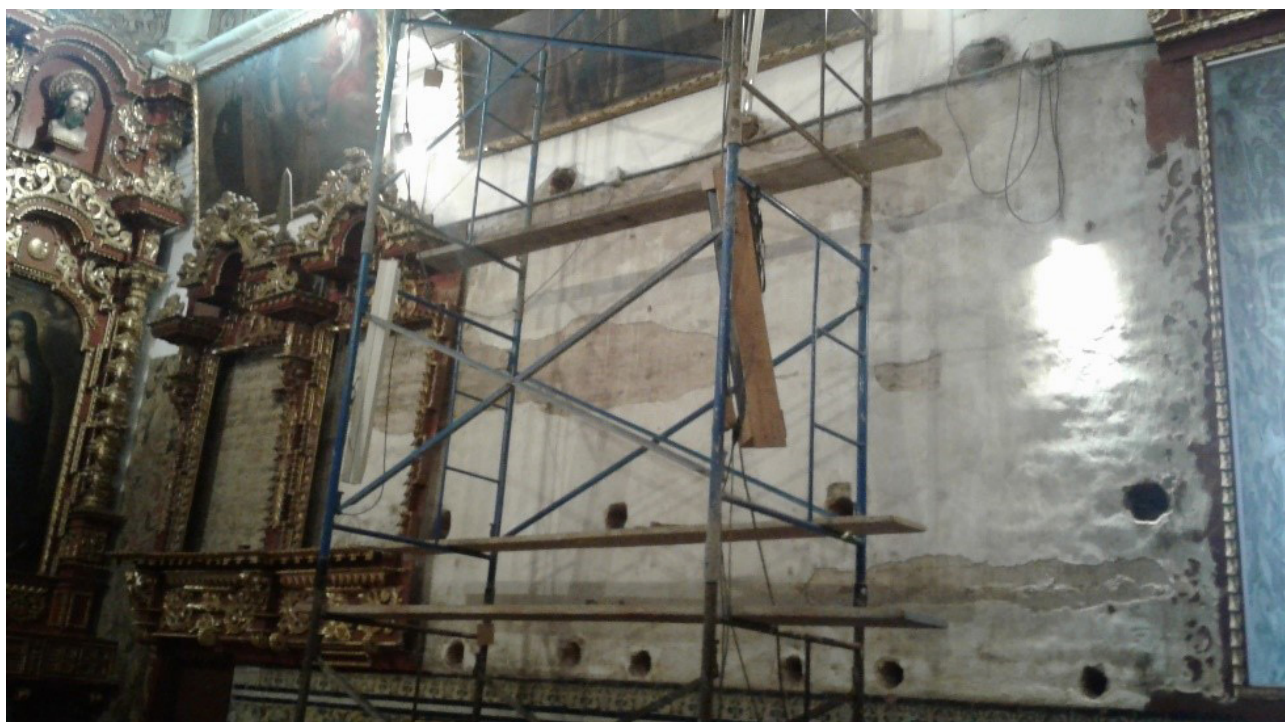
Fig. 9. Pared lateral derecha de la sacristía durante el proceso de restauración de los lienzos y retabillos en 2019. Fotografía: Autora.
