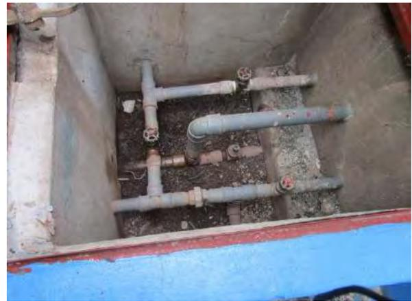
Foto: Caja de válvulas de reservorio de Suaray.
