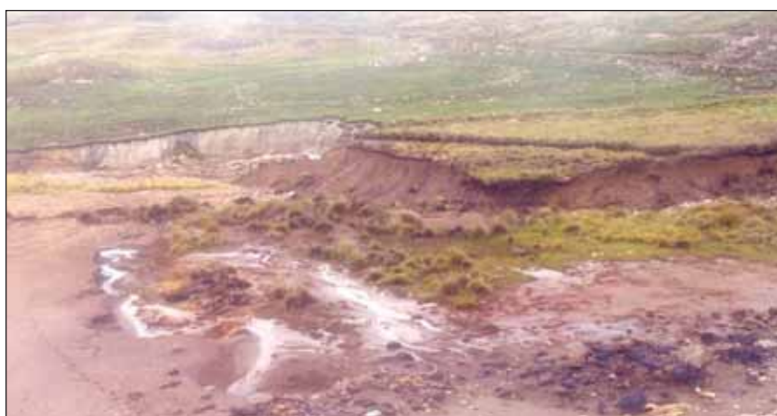
Foto 8: Afloramiento de Agua Subterránea al Pie del dique, Aguas Abajo de la Presa
