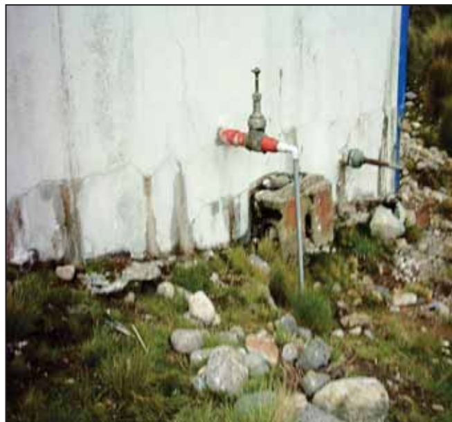
Foto 10: Tubería de aducción que abastece a los campamentos
