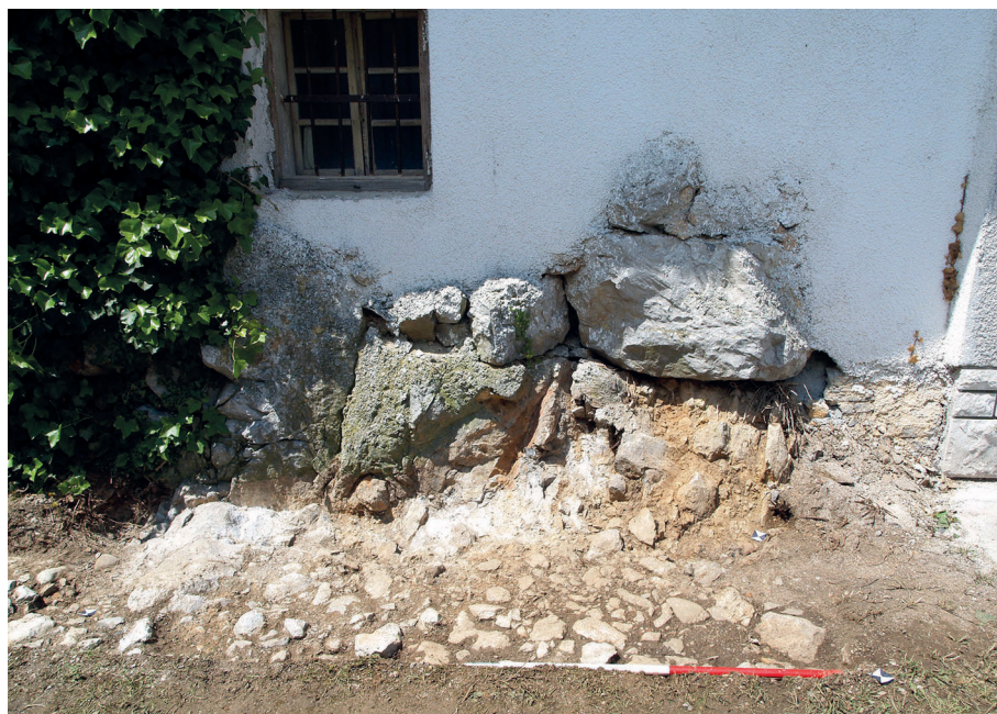
Sl. 8: Podpeč, sonda 1. Matična kamnina na kateri je zgrajena vzhodna stena hiše kmetije Svete (Vehar), Podpeč 44. Fig. 8: Podpeč, Trench 1. Bedrock on which the eastern wall of the house of the Svete farm (Vehar) Podpeč 44 is built.
