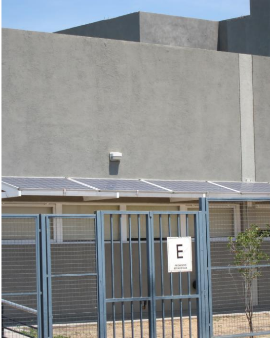
Fig.7: un edificio conectado a la red en Salta
