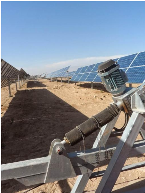
Fig. 9: Planta de 20MW en Perú
