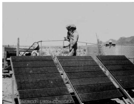
Fig. 1. Una de las primeras instalaciones en Salta
