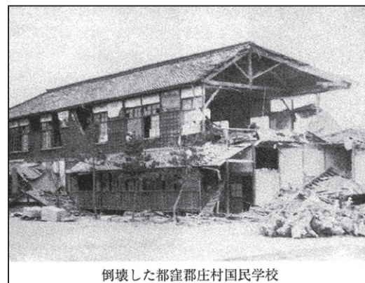
写真1 昭和南海地震によって倒壊した都窪郡庄国民学校。岡山地方気象台所蔵。
