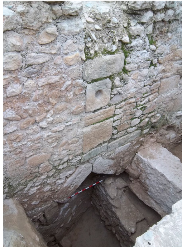
Figura 7. Fotografía donde se distingue la abertura que sirve de desagüe de una cloaca, situada en la base de uno de los pilares de la muralla. Los datos arqueológicos indican que esta construcción sería anterior a la muralla –seguramente alto-imperial– y que el paramento defensivo se adaptó a la misma (fotografía propia).
