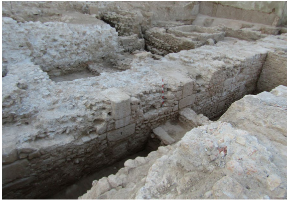
Figura 5. Vista exterior de la fortificación, en la que se puede observar el tipo constructivo de opus africanum (fotografía propia).
