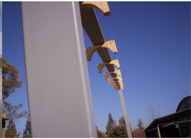
Figura 6: Etapa constructiva del concentrador secundario
