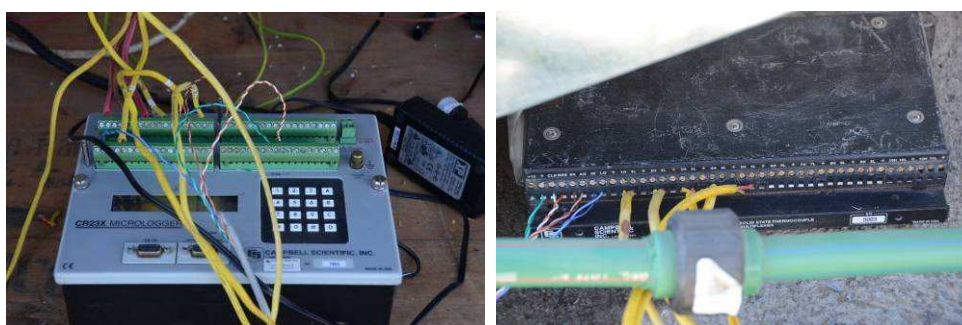
Figuras 8 y 9 – Instrumental: Datalogger y multiplexor utilizados. Se aprecia conexiones de termocuplas.
