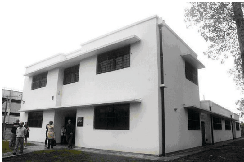
Nuevo edificio anexo compartido entre el INIBIOLP y el Centro de Investigaciones Cardiovasculares (CIC).
