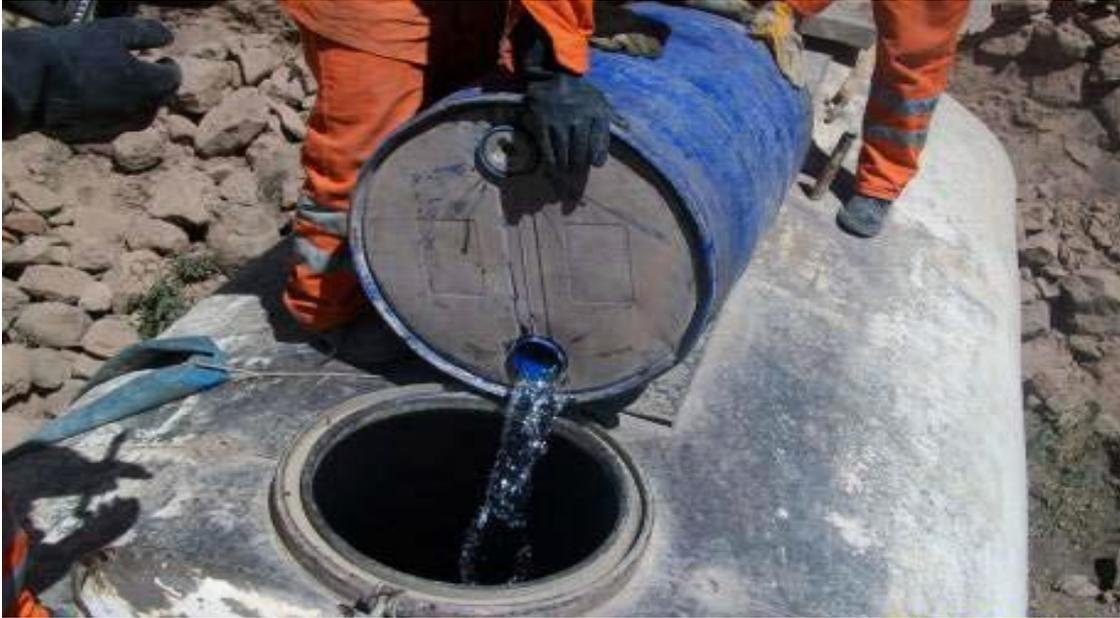
**Foto 07: Proceso de preparación del cloruro de calcio en la cisterna**
