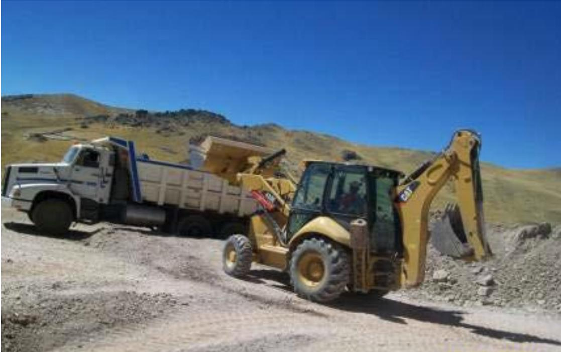
**Foto 05: Vista del proceso de carguío al volquete**
