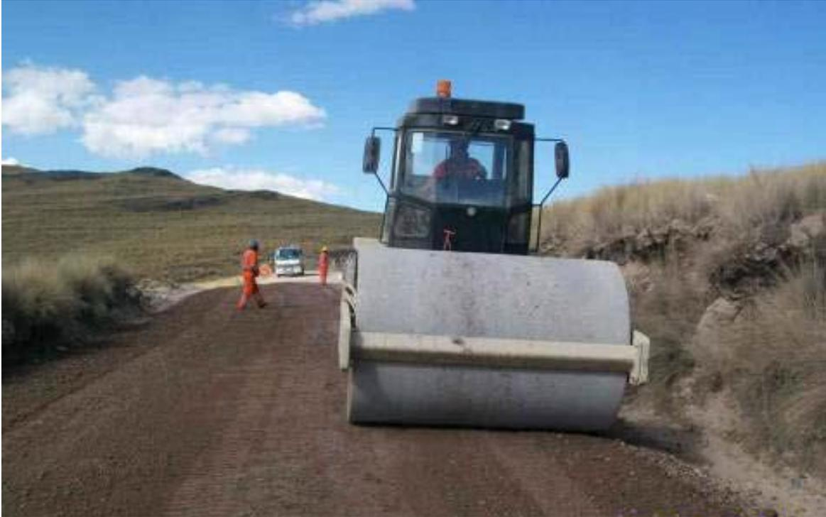
**Foto 09: Ciclo de compactación a nivel de rasante, con rodillo liso de 12 toneladas**
