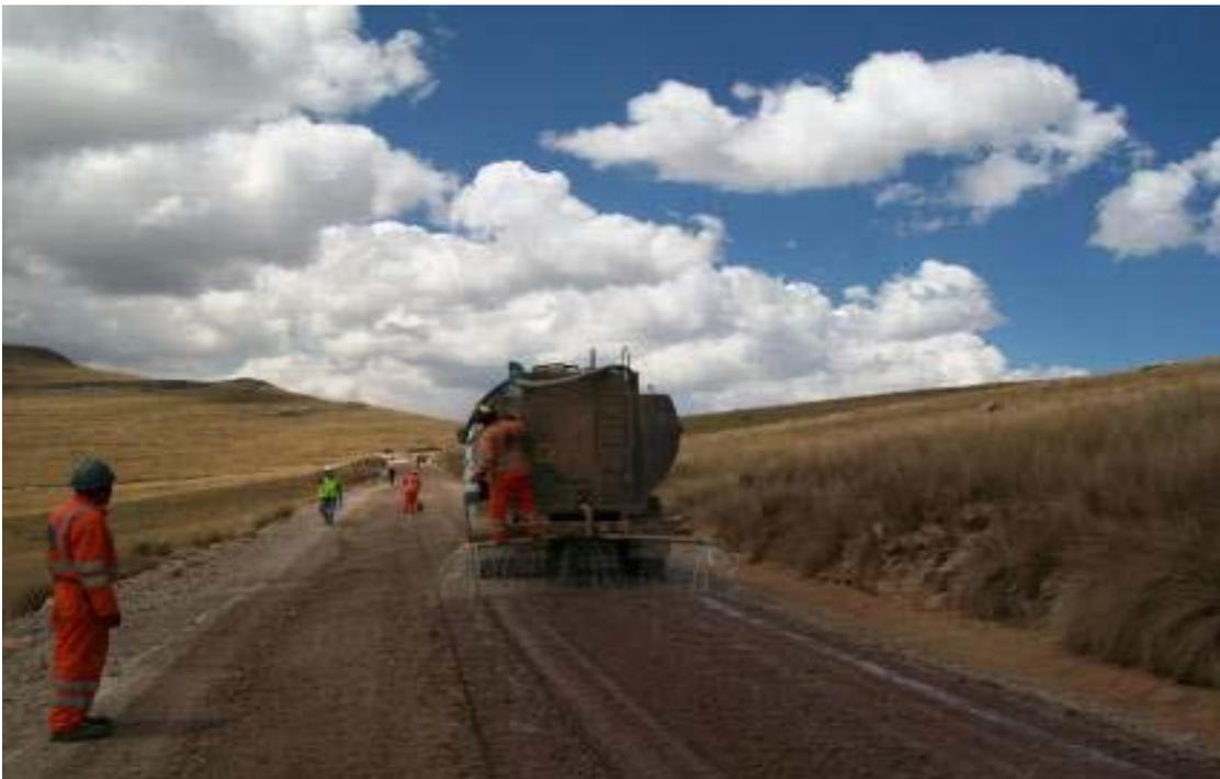
**Foto 08: Proceso de regado con aditivo químico de cloruro de calcio**
