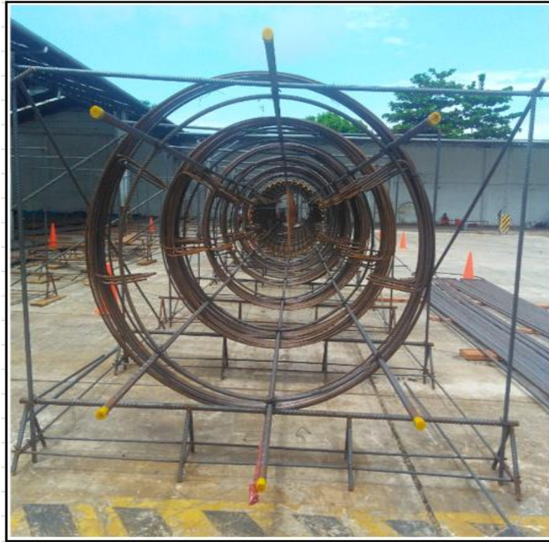
FOTO 3. Armado de pilotes.
