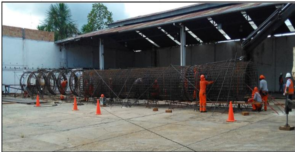
FOTO 4. Empalme entre canastillas.
