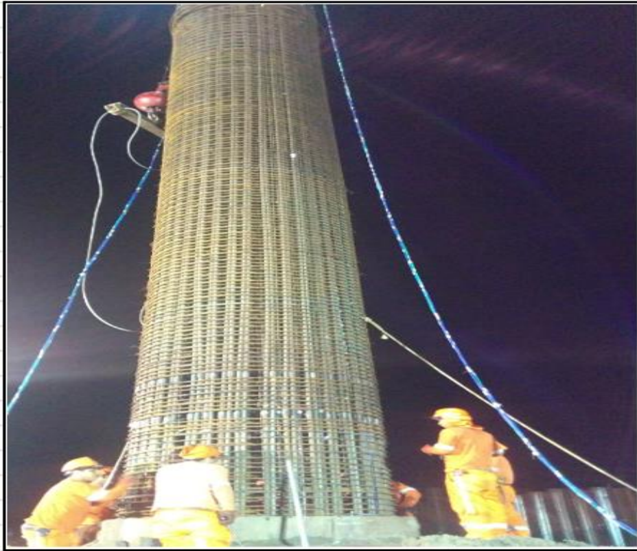
FOTO 11: Montaje de pilotes
