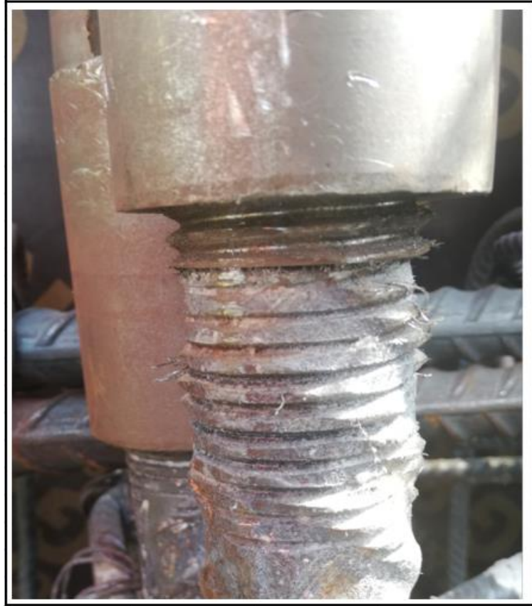
FOTO 9: Empalme a tope entre barras.
