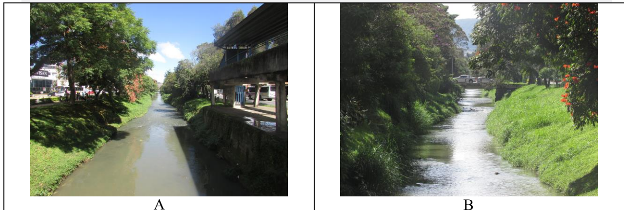
Figura 5 A e B – Em seu trecho retelinizado (A), o ribeirão dos Poços retoma o meandramento (B) ao distribuir a matéria trabalhada no leito, buscando atingir o seu padrão original.
