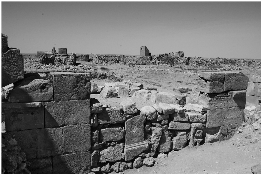
Abb. 4. Gheriat el-Garbia. Porta praetoria mit spätantiker Zusetzung der Durchfahrt mit Spolien.
