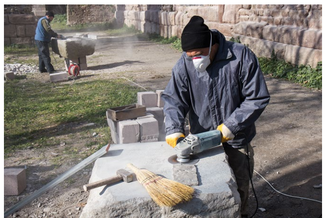
Abb. 90: Bergama, Capacity Building. Steinmetzausbildung
