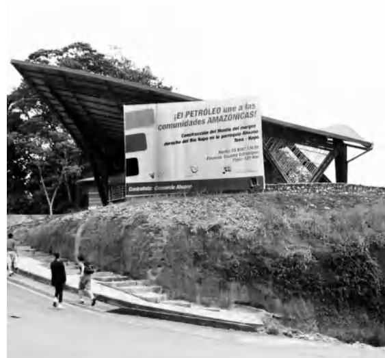
Figura 4. Publicidad sobre la construcción del Muelle Punta Ahuano. La inscripción resalta “EI PETRÓLEO une a las comunidades AMAZÓNICAS” Fuente: archivo del Ingeniero Patricio Cevallos.
