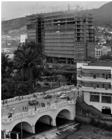
Foto 9: Cantiere Progetto CAM, Cali (circa 1972) Archivio G. Samper, Foto: Álvaro González
