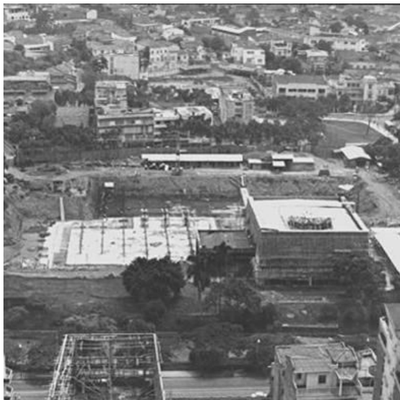
Foto 8: Cantiere Progetto CAM, Cali (circa 1970) Archivio G. Samper, Foto: Álvaro González
