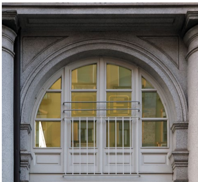
Figura 13. Casa delle Colonne, corso Matteotti, lo stesso elemento costruttivo di Antonelli: la ringhiera solo in corrispondenza delle parti apribili dell'infisso. Da notare l'integrazione dell'altezza, a regolarizzazione della protezione con elementi orizzontali nella stessa larghezza della ringhiera originale.
