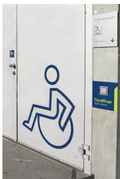
01 Alcuni esempi di pannelli con forte contrasto cromatico e posizionamento accessibile all'Università di Dresda. Studio Kw, 2017
