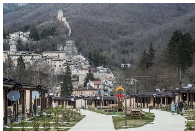
Figura 1. Il borgo fortificato di Castelsantangelo sul Nera visto dalle nuove S.A.E. (fotografia di Filippo Romano, marzo 2019).
