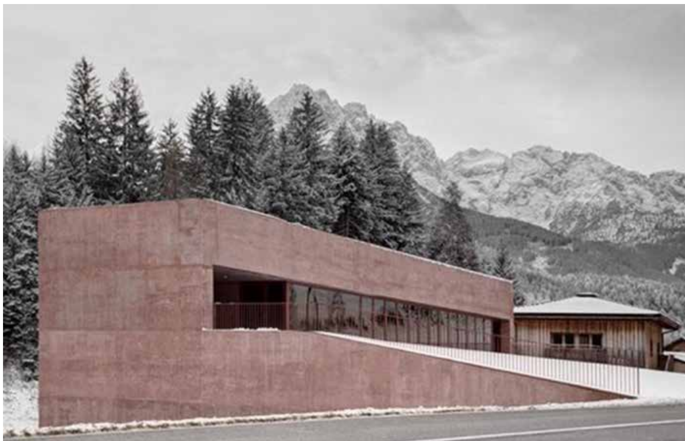
La caserma del Comune di San Candido (BZ). Prospetto su strada. ©Gustav Willeit.
