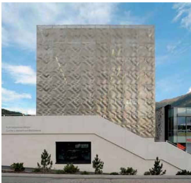
Vertikale Kletterhalle a Bressanone.
