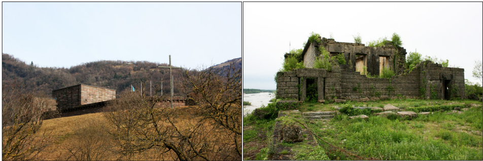
Figg. 11, 12. Il cimitero tedesco di Quero, 1936-1939; la Totenburg incompiuta di Pinzano, abbandonata dal 1943 [foto di Elena Pirazzoli, 2019-2020]
