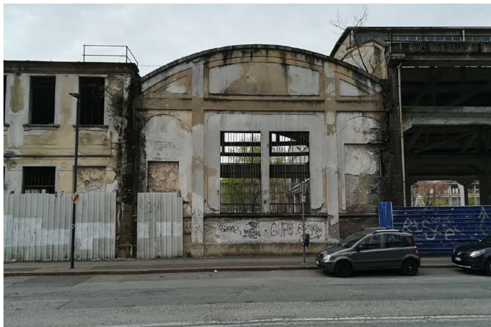
Fig. 4 - Ciò che resta della Fabbrica Nebiolo sul fronte di corso Novara, dopo le demolizioni risalenti ai primi anni 2000. Fonte: M. Zucca.
