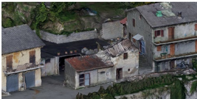
Figura 5. Modello 3D mesh texturizzato derivato da fotogrammi orientati acquisiti con drone Inspire 1 del gruppo VVF relativo a fenomeni di danni e crolli nell'area sud.
