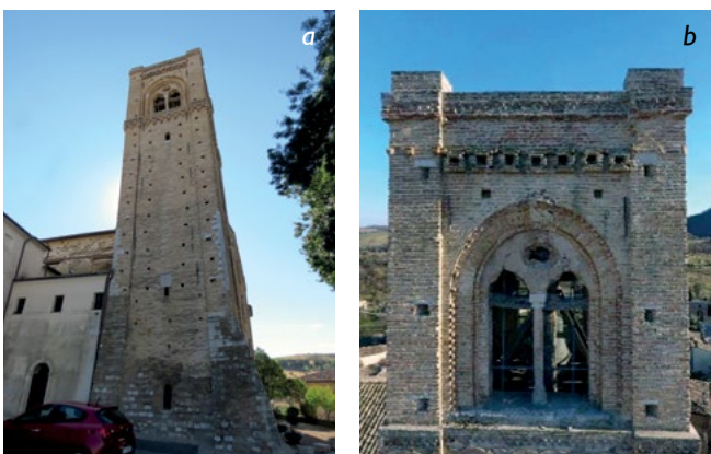
Figura 3. Vista della Torre di San Severino (a) e dettaglio della cella campanaria in uno scatto acquisito tramite UAV (b).
