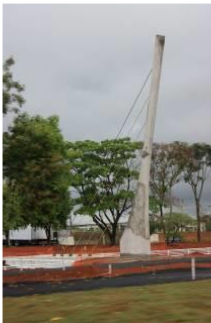
Foto 8. Obras nas margens do Rio Preto. Fonte: Mayra Fernandes, 2012.
