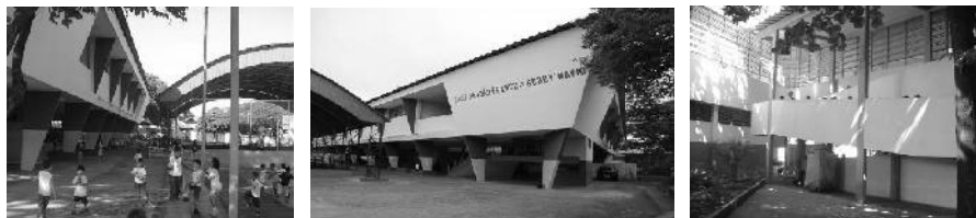
Fotos 10 a 12: O edifício histórico, o anexo e a adequação à acessibilidade
