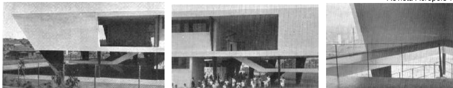
Fotos 5, 6 e 7: Cantos do edifício: transição da circulação vertical com a horizontal, vista para a cidade.
