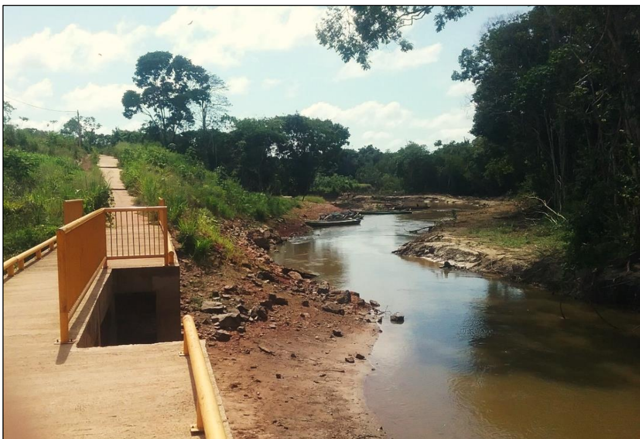
Figura 4 - Trecho do igarapé panelas no RUC Laranjeiras
