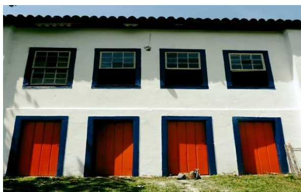
Figura 3. Fachada restaurada da Fazenda Rio Vermelho
