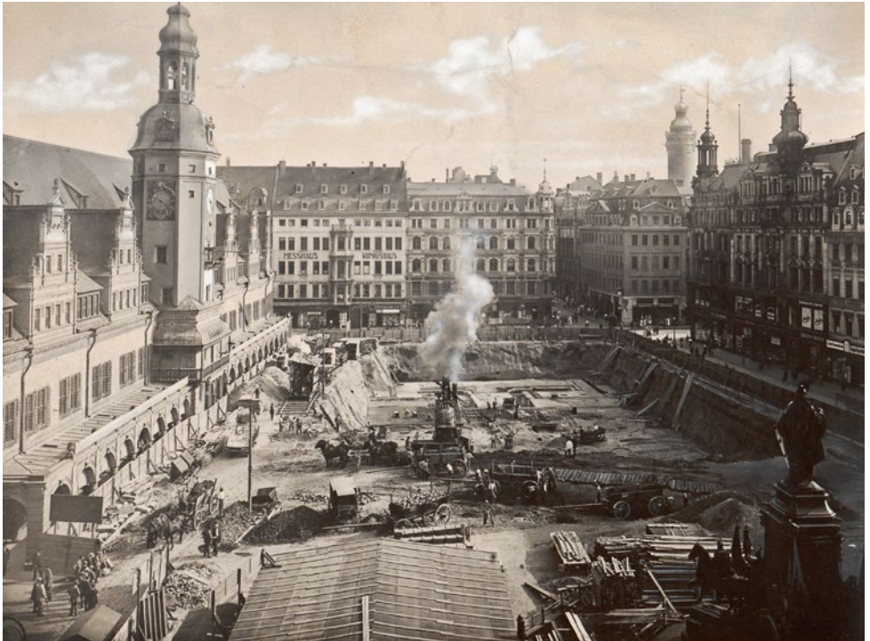
Abbildung 3: Paul Faulstich: Bauarbeiten zur Untergrund-Messehalle am Leipziger Markt, August 1924 (Quelle: Sächsisches Staatsarchiv, Staatsarchiv Leipzig, Bestand 20202 Leipziger Messeamt (I), Nummer F 3308).
