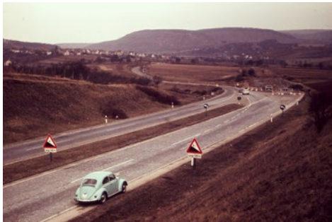
Abbildung 6: Heinz Pietsch: Ende der Autobahn 81 bei Weinsberg, 1963 (Quelle: Kreisarchiv Tübingen, Bestand Heinz Pietsch, Signatur FPA-H2-1338).
