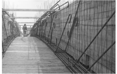
Abbildung 1: Annemarie Brenzinger: Bau der Ochsenbrücke in Freiburg, Eiseneinlage des Hauptträgers um 1912; Negativglasplatte, 18 Zentimeter hoch, 24 Zentimeter breit (Quelle: Badisches Landesmuseum – Außenstelle Südbaden, Inventarnummer BA 2000/65).
