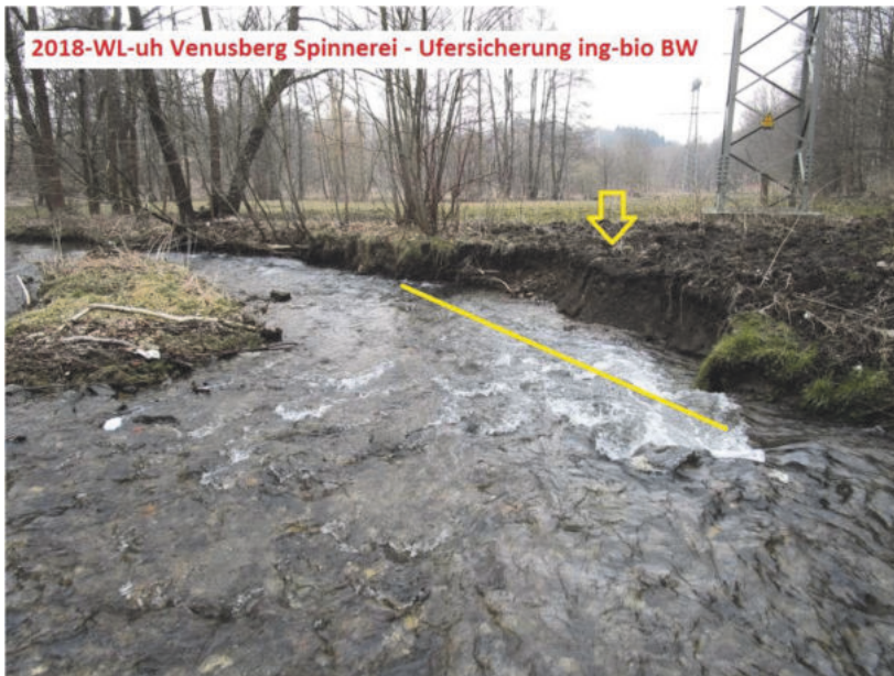
Abbildung 20: Gefährdeter Flussabschnitt der Wilisch vor der Ufersicherung
