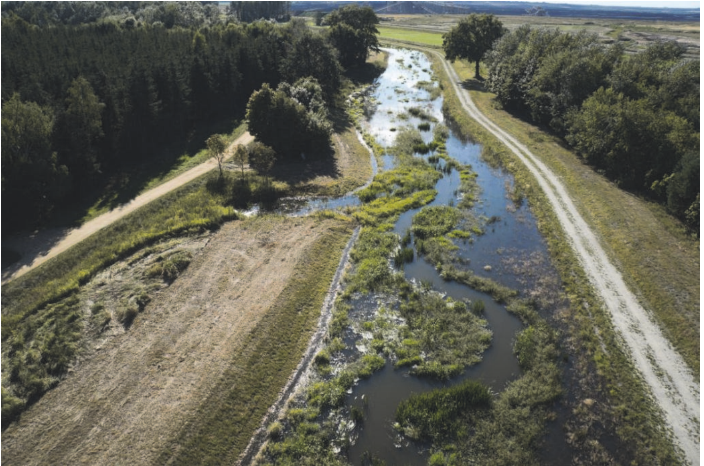
Abbildung 16: Umverlegung Weißer Schöps, Los 2: Neubaustrecke
