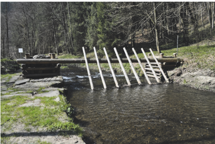
Abbildung 11: Totholzfang in der Polenz nahe der Frinztalmühle
