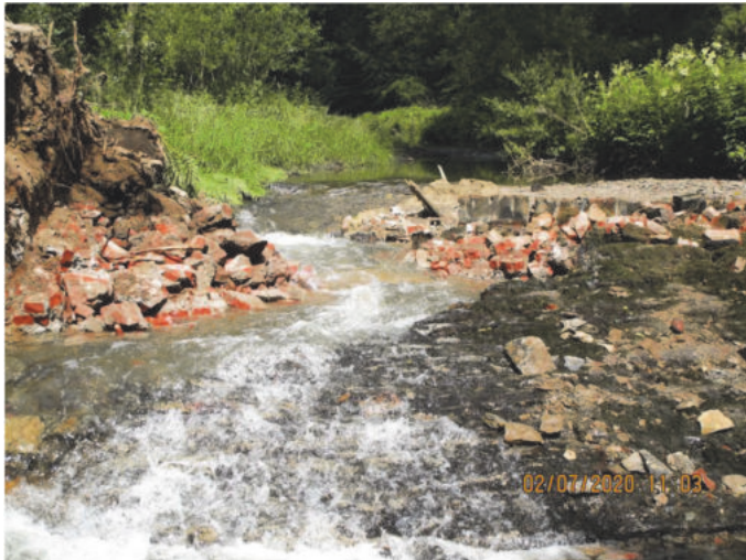
Abbildung 18: Rückbau des Wehres Ferienpark/Wilisch – Bauphase
