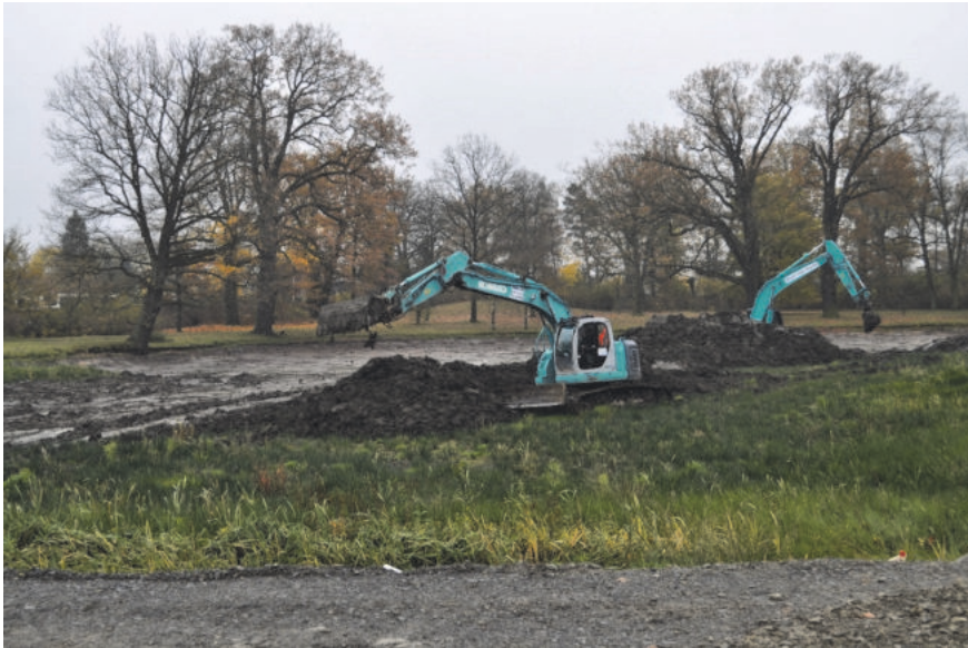
Abbildung 12: Entlandung eines Karpfenteiches
