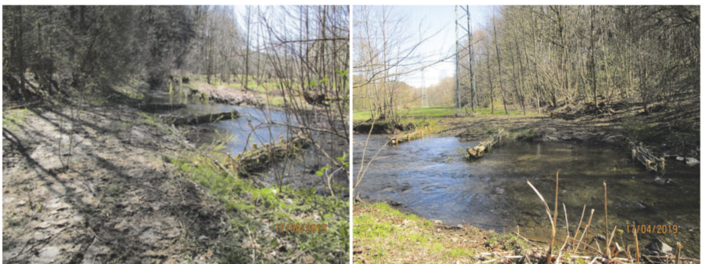
Abbildung 21: Abschnitt der Wilisch mit eingebauten Faschinen
