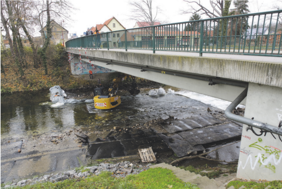
Abbildung 23: Während der Baumaßnahme
