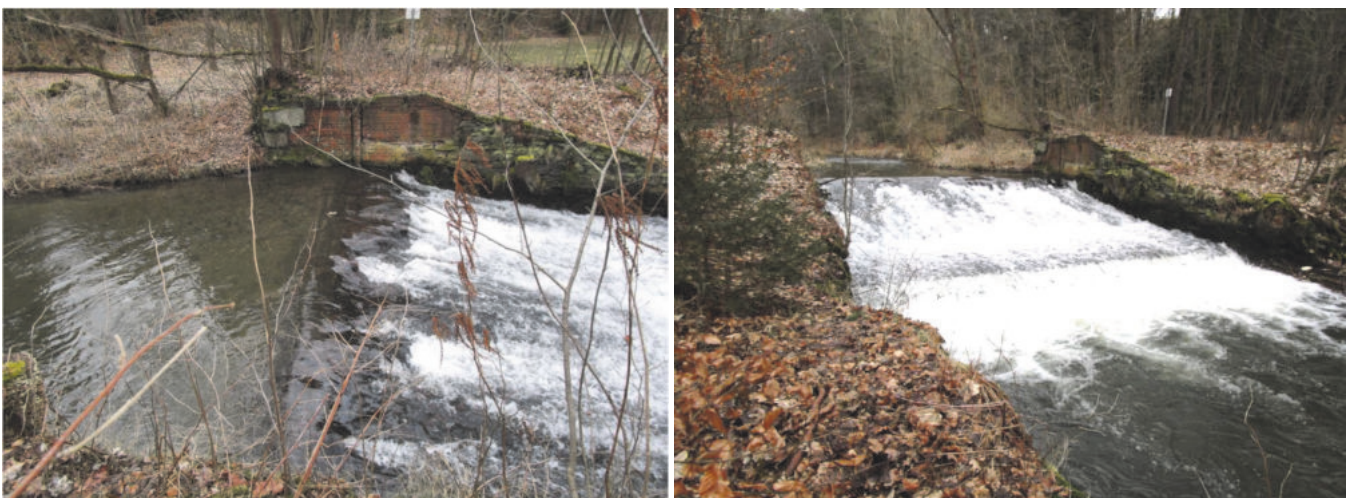
Abbildung 17: Wehr Ferienpark (Wilisch) vor dem Rückbau
