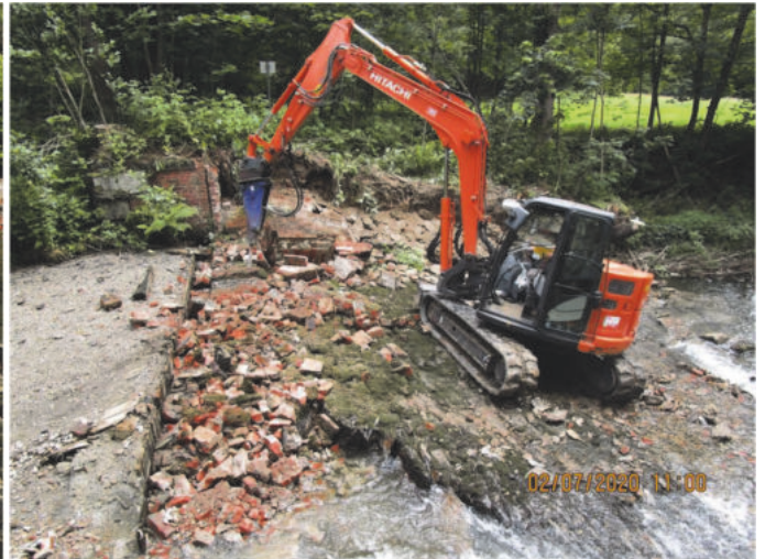
Abbildung 18: Rückbau des Wehres Ferienpark/Wilisch – Bauphase
