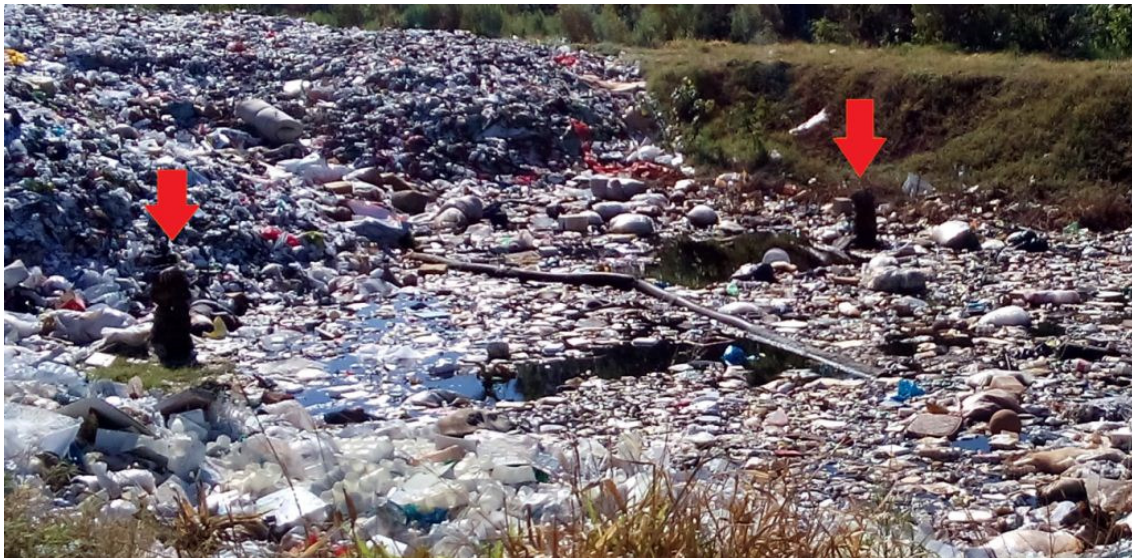
Figura 4 - Sistema de drenagem utilizado pelo empreendimento.
