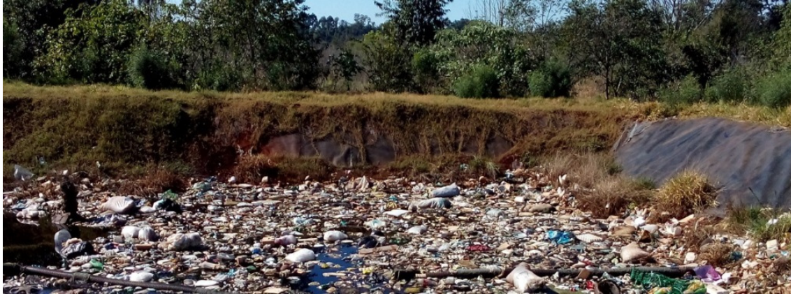
Figura 2- Impermeabilização da base e laterais do aterro com geomembrana.
