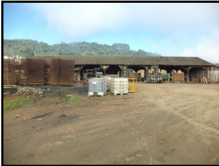
Figura 4 - Containers de produtos químicos sem cobertura e sem bacia de contenção.
