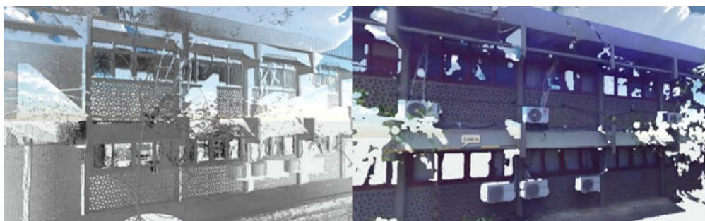
Figura 6. Fotomontagem da sobreposição da nuvem de pontos em modelo de visualização preto e branco (esquerda); e colorida (direita). Fonte: Imagens capturadas do software FARO Scene. 2018.
