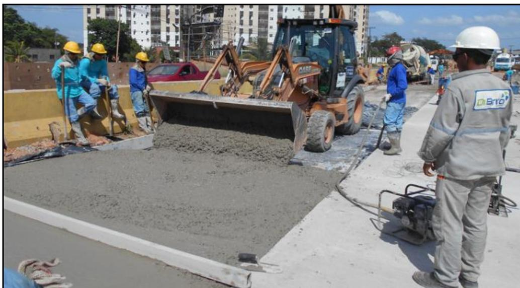
**Figura 13. Concretagem do pavimento (Silva et al., 2018)**
