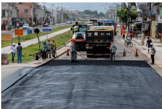
Figura 7 – Rua Timbiras. Canal foi posto em galeria sob a faixa de grama.
