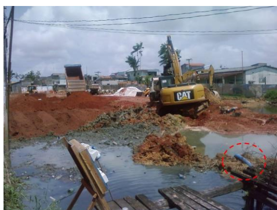
Figura 5 – Canal da Bernardo Sayão sendo dragado, drenado e aterrado. Fonte: o autor (novembro/2012).
