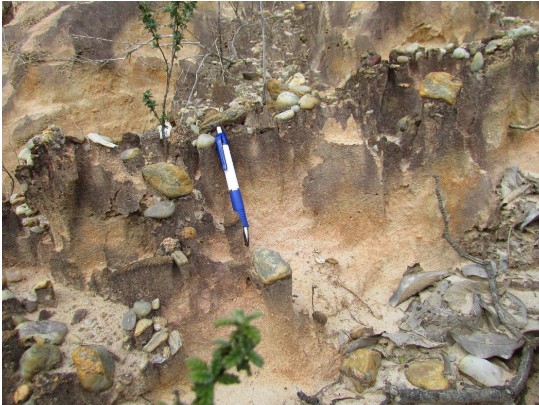
Figura 11 - Pedestais no interior da voçoroca.
