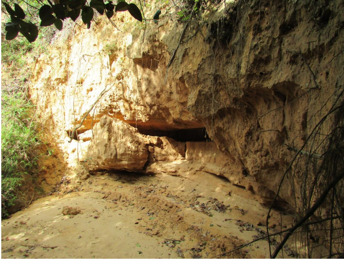
Figura 12 - Queda de blocos do material arenoso das paredes internas da voçoroca.
