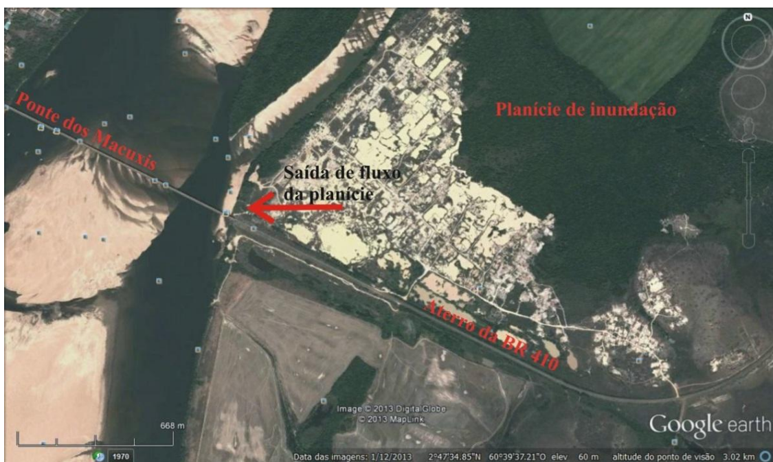
Figura 5: Aterro que atua no represamento da planície de inundação localizada junto à margem esquerda do rio Branco, nas proximidades da cidade de Boa Vista (localizada junto a margem direita do rio Branco). Neste local o fluxo de cheias da planície de inundação é jogado de volta ao canal na cabeceira da ponte dos Macuxis. Pode ser observado ainda uma fonte potencial de sedimento em suspensão devido as atividades de oleiros no local (Fonte: GeoEye, 2014).
