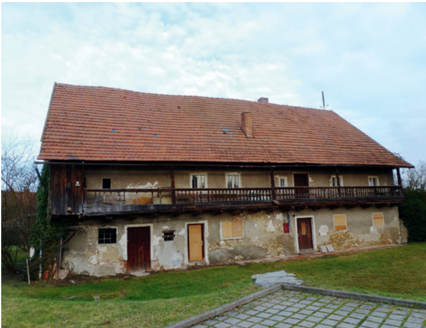
Abb. 1: Das Holzer-Haus in Mintraching vor seiner Sanierung
