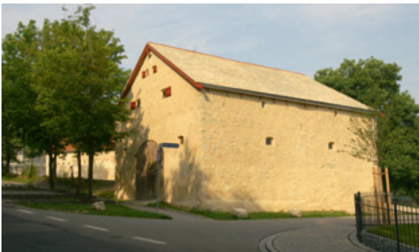
Abb. 3: Der Weismannstadel in Hemau nach seiner Sanierung im Jahre 2013
