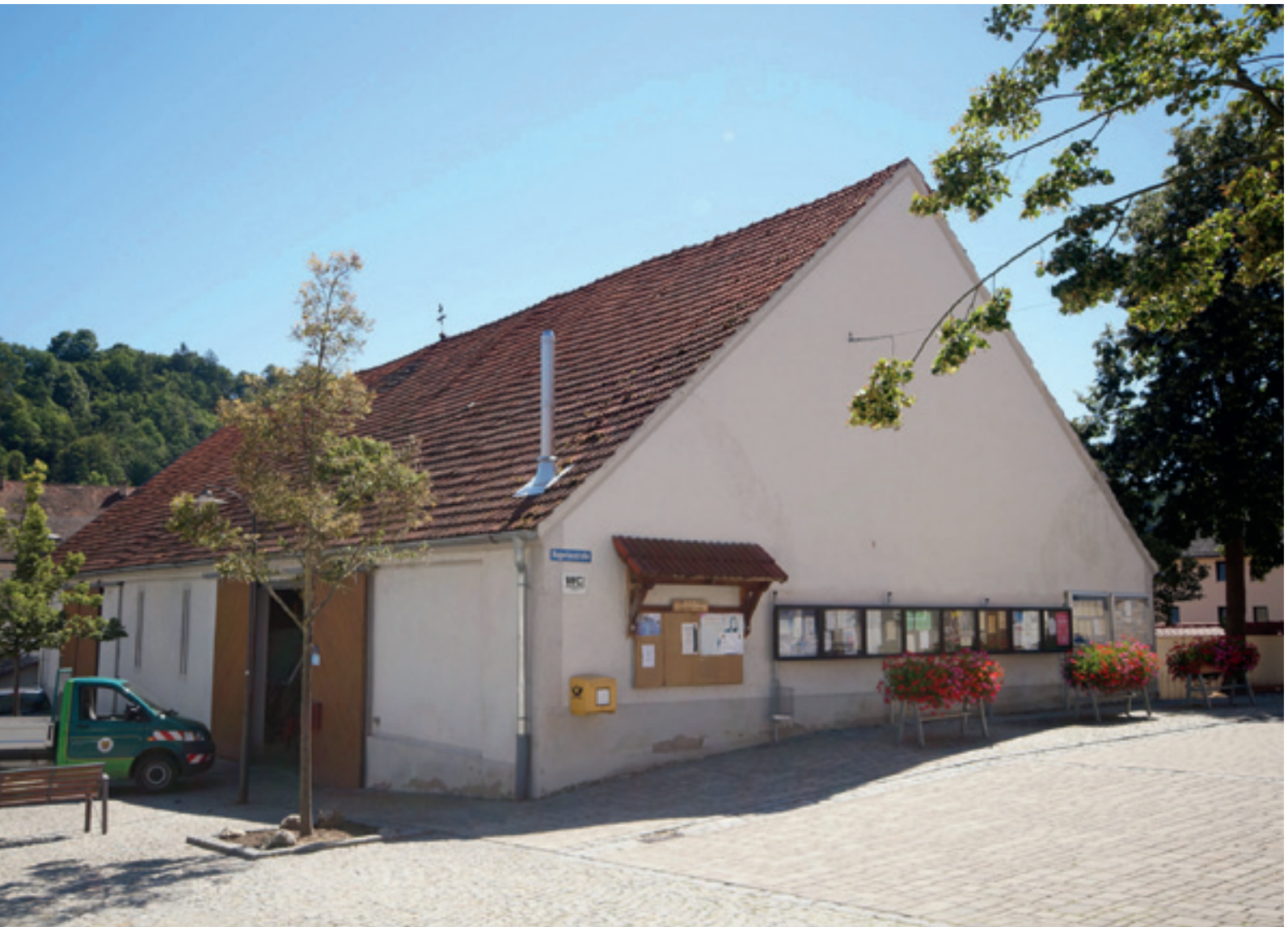
Abb. 2: Der Klosterstadel vor der Sanierung
