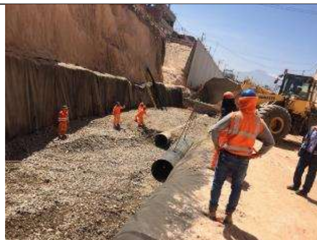
-Corte de tramo no intervenido por contratista en lado derecho 1+550 a 1+600
