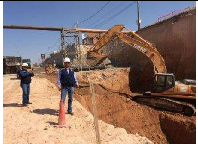
-Verificación de trabajos en corte de vía para sistema de drenaje subterráneo.
