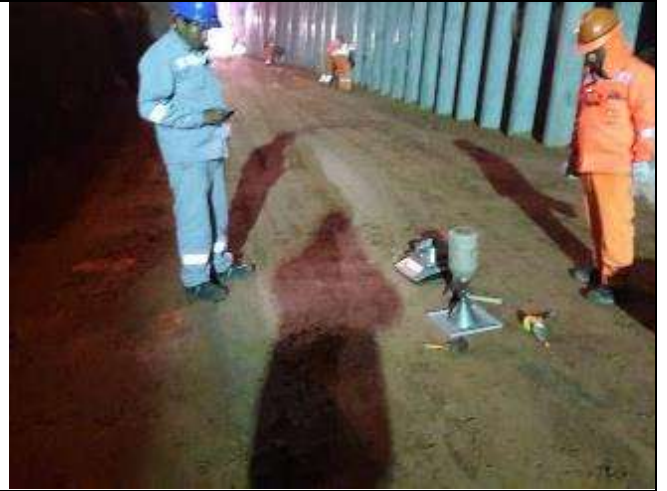
-Verificación de compactación en turno noche.
