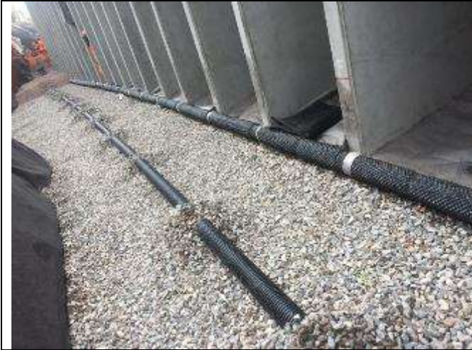
-Verificación de instalación de tubería perforada de sistema de drenaje.
