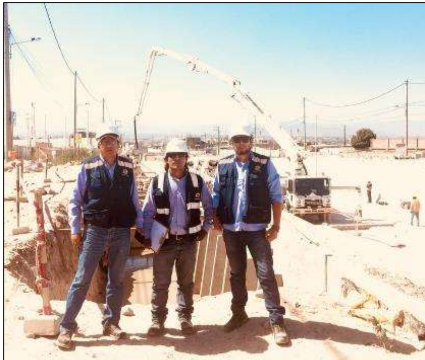
Verificación de controles de calidad para vaciado de zapatas
