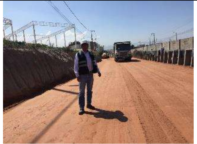
-Verificación de compactación de rellenos en lado izquierdo 2+200
