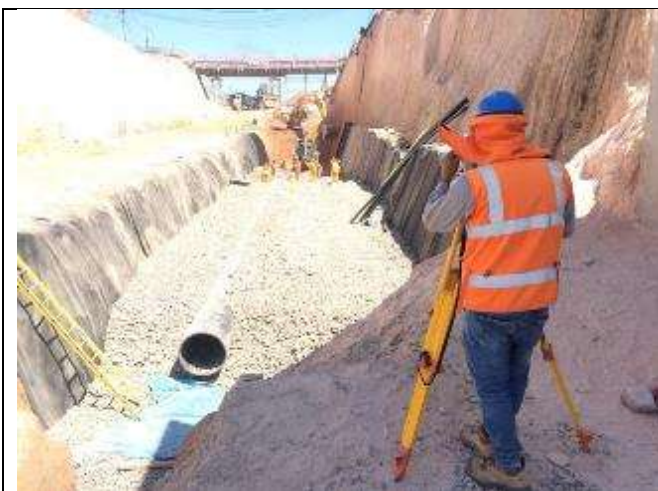
-Control y verificación de pendiente y alineación de tubería de drenaje subterráneo Madre de Dios
