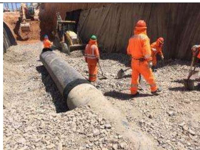
-Relleno de material over en Madre de Dios lado izquierdo prog. 1+600.
