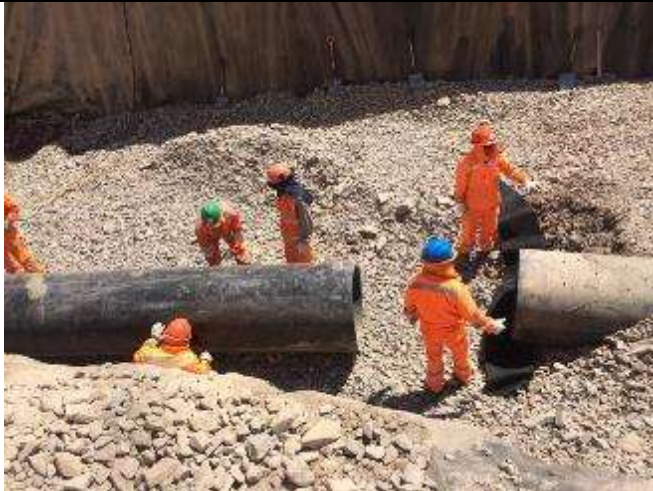
-Corte de tramo no intervenido por contratista en lado izquierdo 1+550 a 1+600
