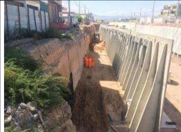
-Relleno y compactado por capas entre progresivas 2+070 a 2+270 lado Izquierdo de la vía.
