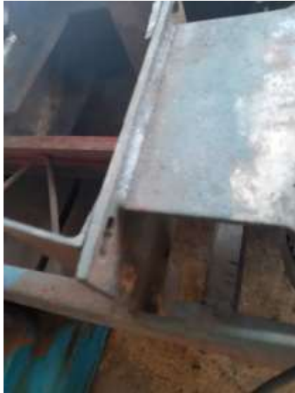
Figura 87. Construcción de bases de motor y reductor
