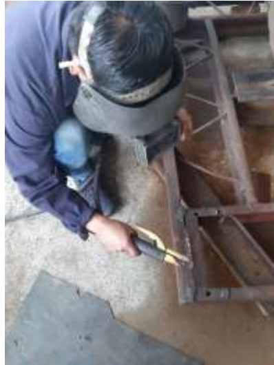
Figura 85. Construcción de base torno
