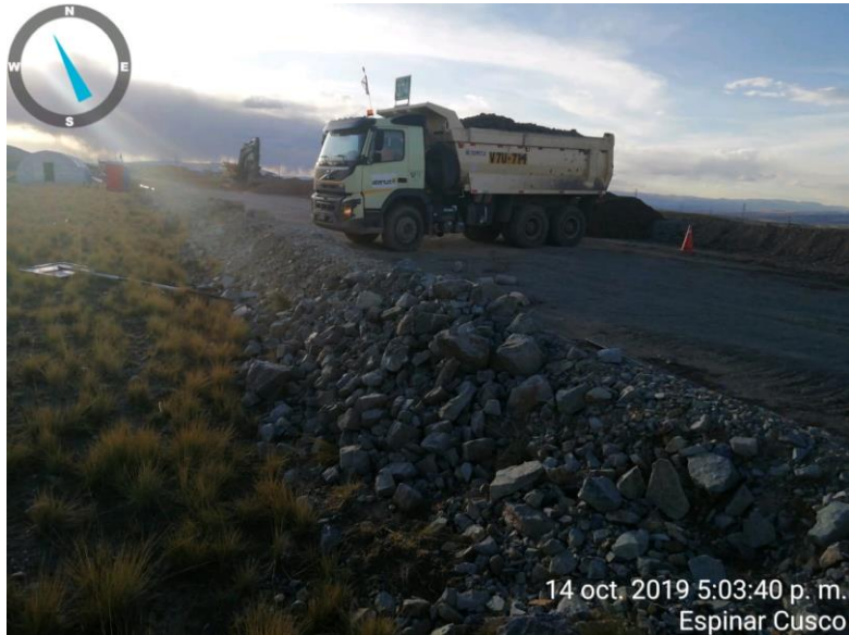
Figura 7. Descarga de material con camión volquete. Fuente: Propia
