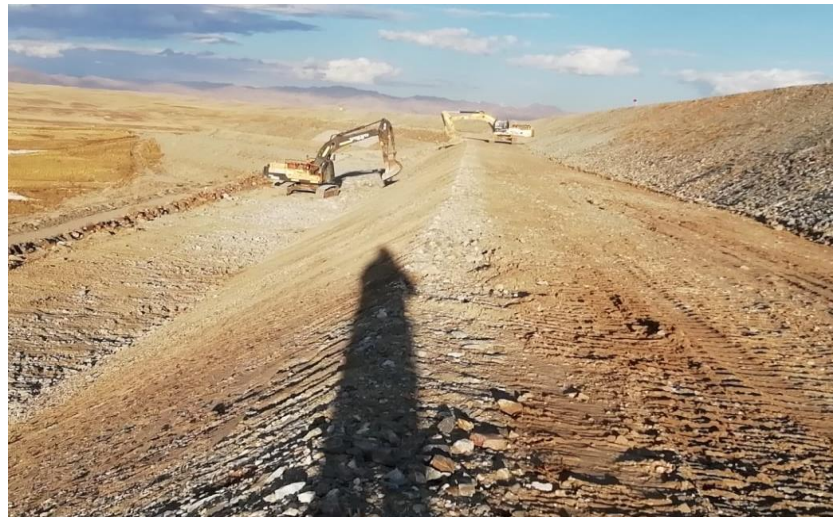
Figura 9. Conformación de taludes con excavadoras – proyecto Ccamacmayo.
