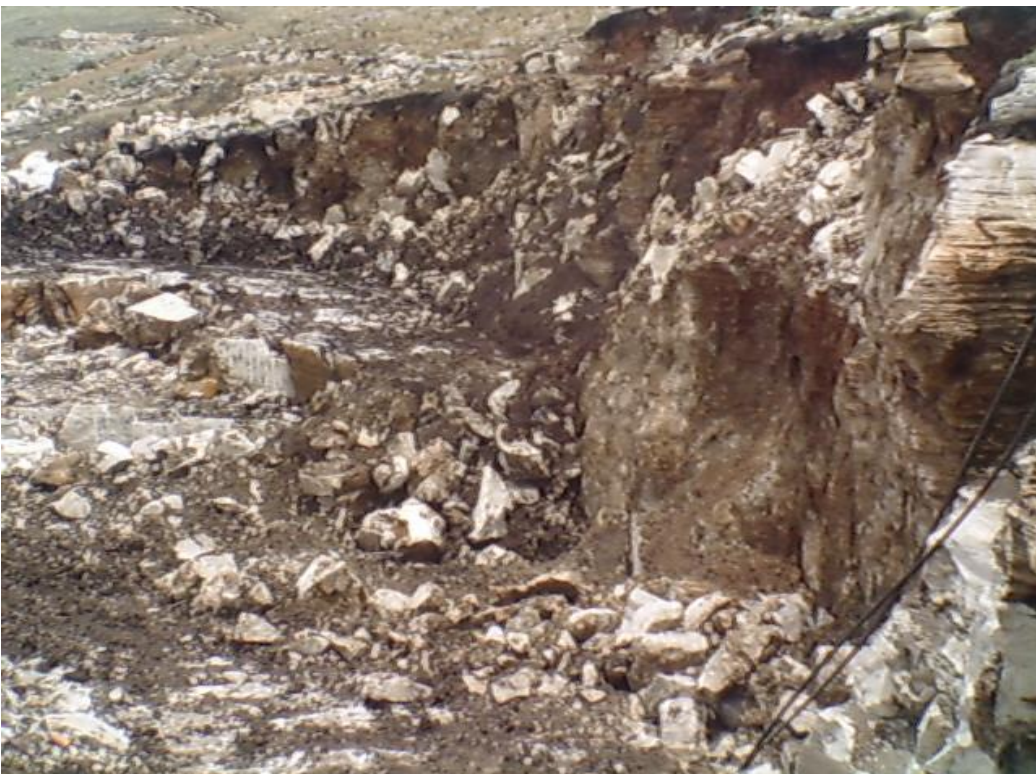
Figura 30. Frente de travertino para extracción de bloques
